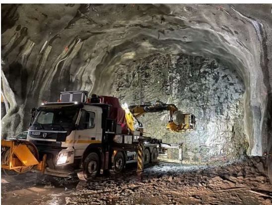
Kort taget av Implenia inne i tunneln.
